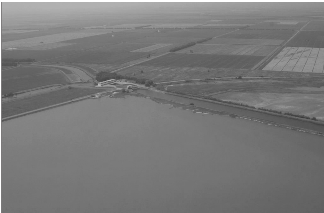
Fig. 5. Margine NW delle Valli, argine Agosta, casone e idrovora Fosse: ben evidente lo stato di ipertrofia delle acque vallive (acque verdi) rispetto alla acque del Canale Fosse Foce (acque blu).
